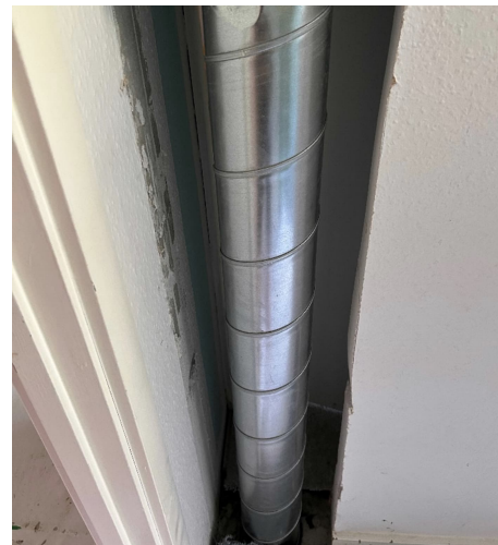
Billede 6 - Ny ventilationskanal i væg
