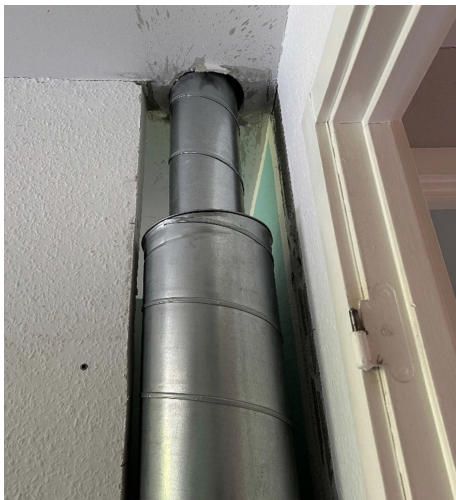
Billede 5 - Ny ventilationskanal i væg
