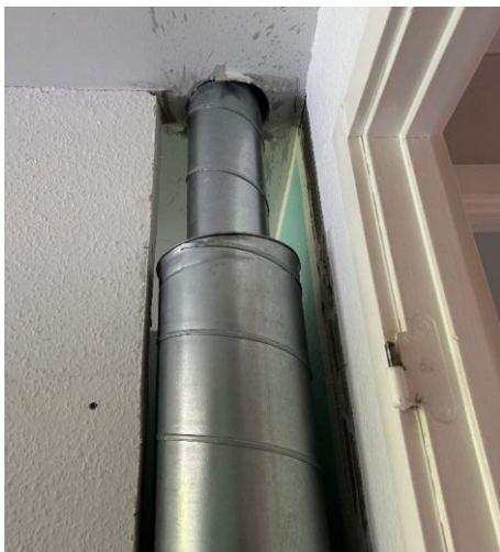
Billede 5 - Ny ventilationskanal i væg
