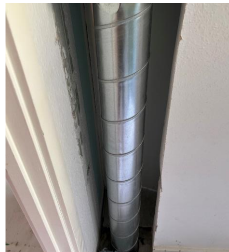
Billede 6 - Ny ventilationskanal i væg
